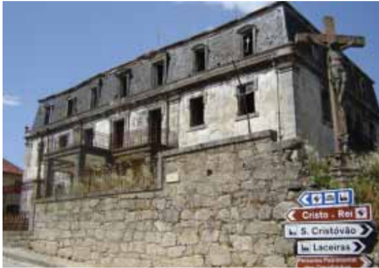
■ Casa do Passal onde morou Aristides de Sousa Mendes
