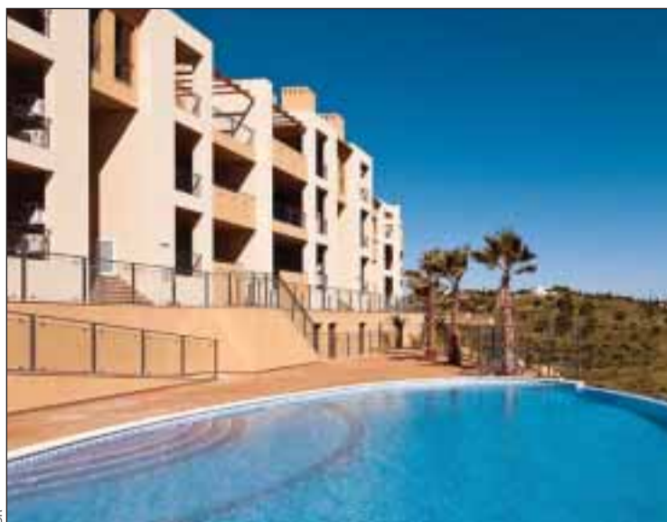
Empreendimento Panorama, em Lagos/Algarve
